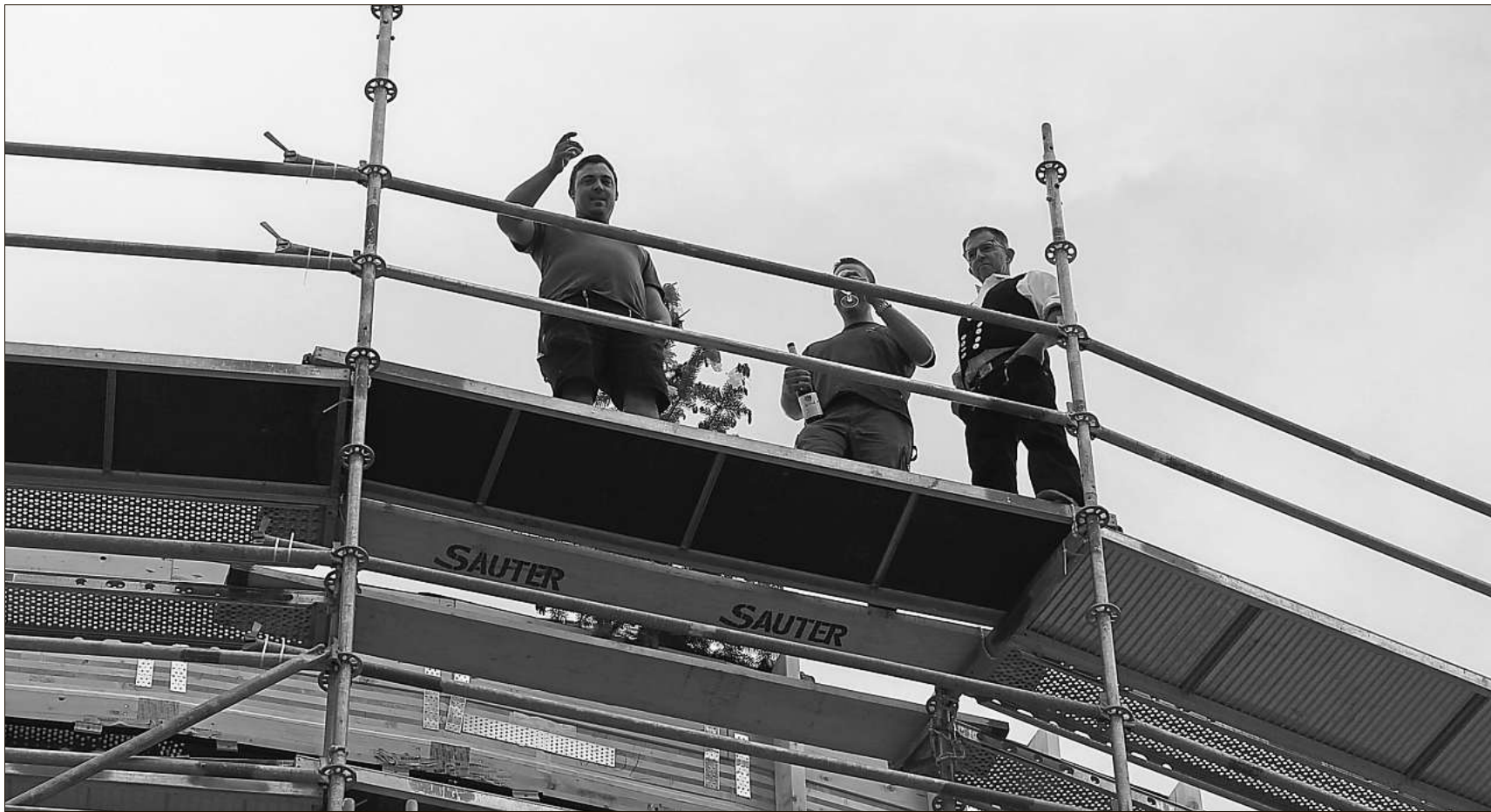
Die Handwerker bei ihrem Richtspruch auf dem Dach des Gebäudes.
